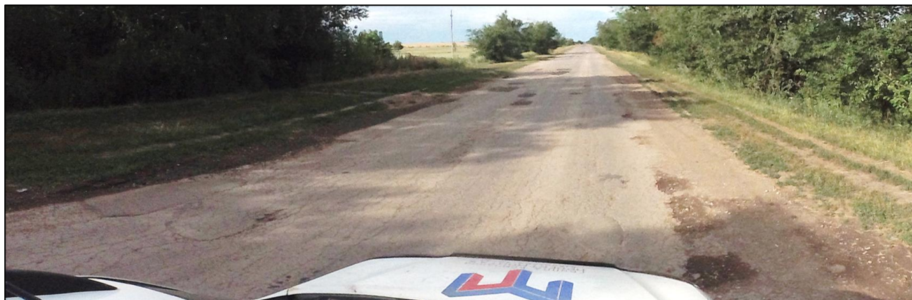
Рисунок 1.3.1.1. Состояние дорожного покрытия а/д ОП РЗ 63 К-00578 «Перелюб-Иваниха» на момент обследования
