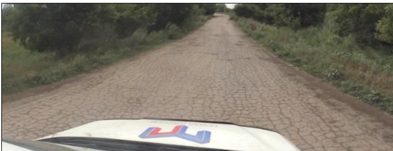
Рисунок 1.3.1.11 – Состояние дорожного покрытия а/д 63-634-425-111-ОП-МП-005 автоподъезд к с. Харитоновка от автомобильной дороги «Озинки-Перелюб» (в том числе мост ч/з реку Камелик) на момент обследования
