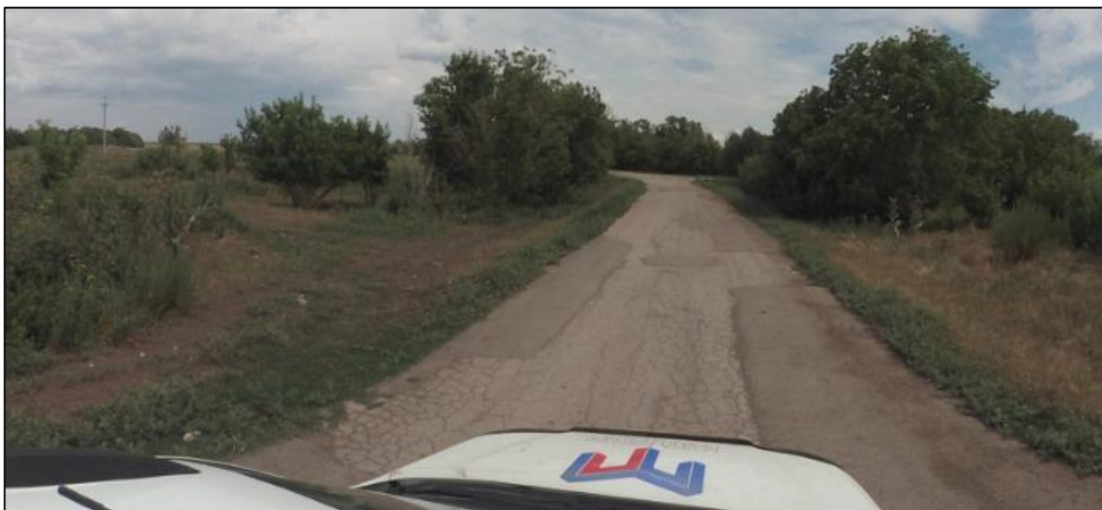
Рисунок 1.3.1.3. Состояние дорожного покрытия автомобильной дороги с. Кучумбетово объездная на момент обследования
